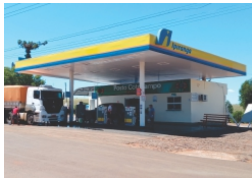
POSTO DE COMBUSTÍVEL CAMPO NOVO
